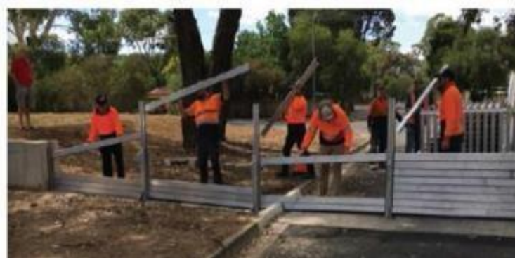
Figura 43 - Barriera temporanea modulare con pilastri e panconi manuali in alluminio
