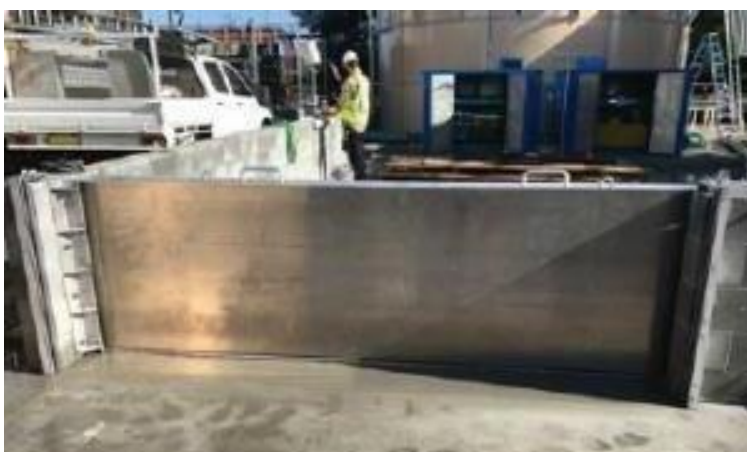
Figura 44 - Paratoia di chiusura a scorrimento orizzontale per un cancello a tenuta idraulica
