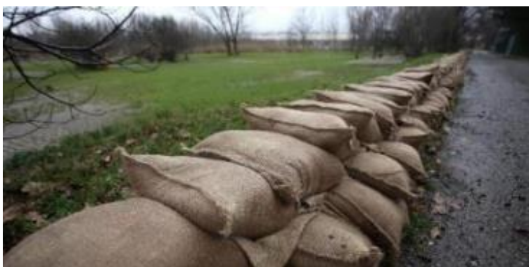
Figura 38 – Barriera temporanea antiesondazione in sacchi di sabbia
