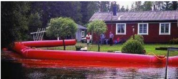
Figura 40 - Barriera temporanea antiesondazione riempita ad aria
