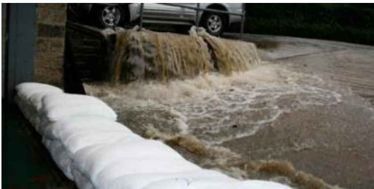
Figura 39 - Barriera temporanea in sacchi riempiti con materiale sintetico assorbente
