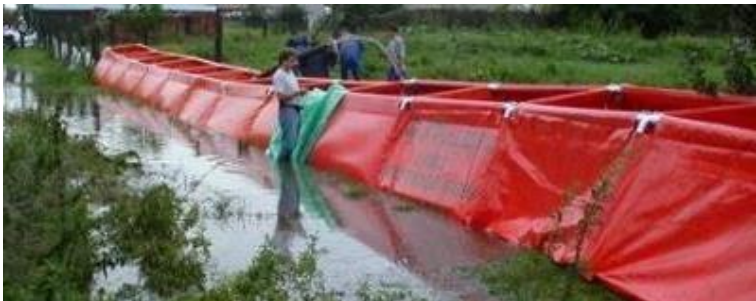
Figura 41 - Barriera temporanea antiesondazione riempita ad acqua
